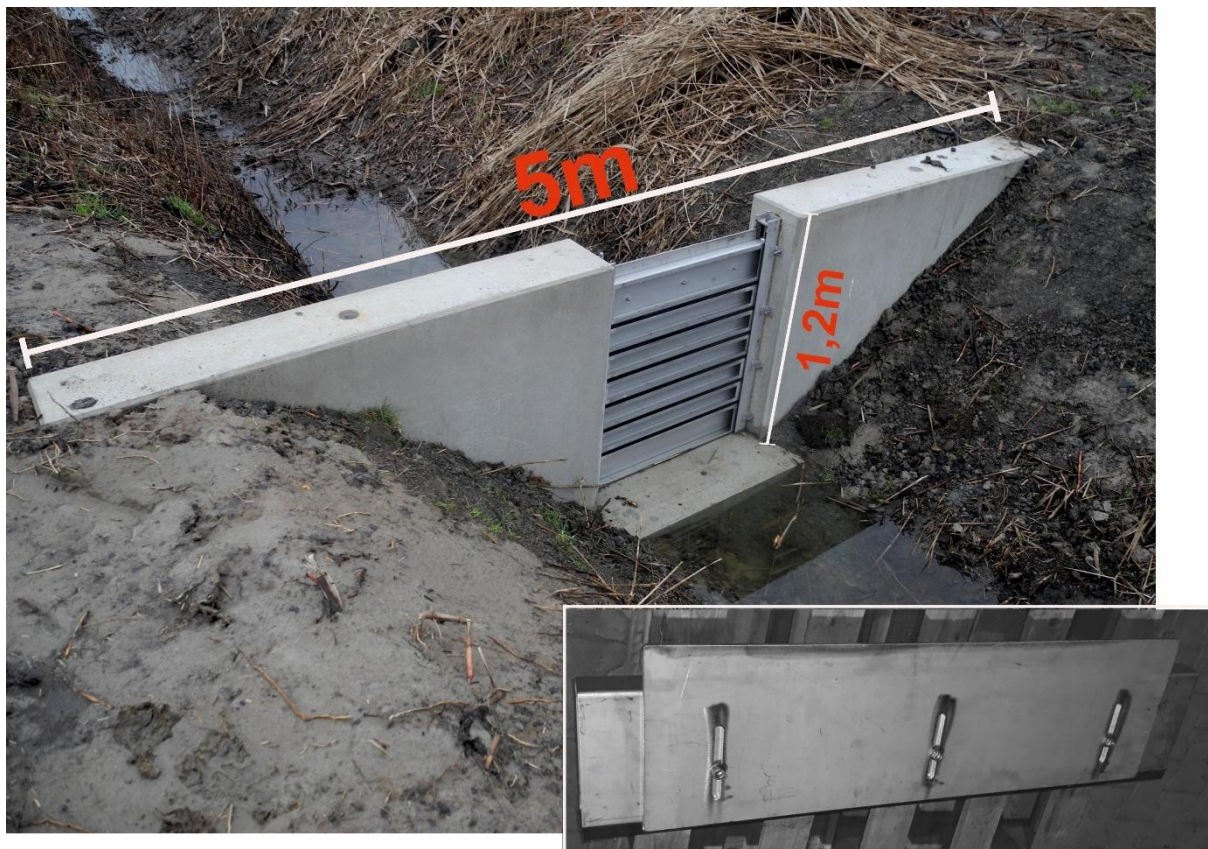
Abb. 2: Die Edelstahlplanken werden in die Stahl-Gleitseiten an der Seite des Betonkörpers eingeschoben. Die oberste Planke ist ein Blech, das nach oben und unten einige cm verstellbar ist (siehe Bild unten rechts). Zudem werden unterschiedlich große Planken in das Wehr eingesetzt.
