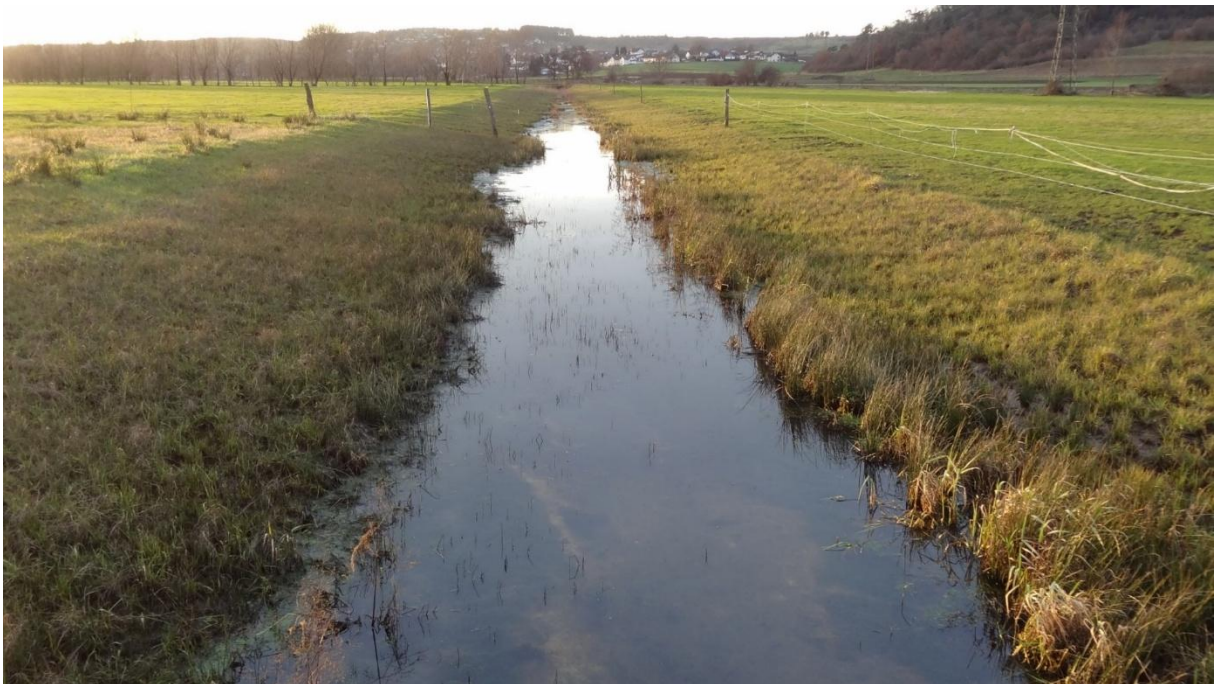
Abb. 4: Die Grabenabflachung erleichtert die Grabenpflege und verhindert, dass Vögel darin verenden.
