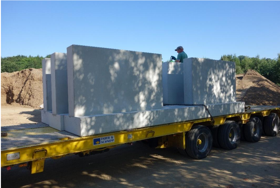
Abb. 3: Transport der Betonkörper.
