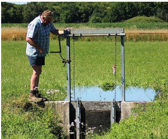
Abb. 2: Links: Der „Erste Bauherr“ und Wässerer der Wassergenossenschaft bedient einen Kurbelschütz in der „Gosberger Zweng“. Foto: Landratsamt Forchheim. Rechts: Das „Gosberger Wehr“ ist eines von zwei Großwehren in den Forchheimer Wässerwiesen.
