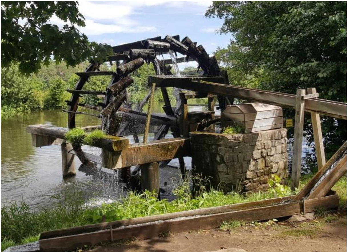
Abb. 3: Wasserschöpfpräder wie dieses bei Hausen an der Regnitz wurden früher genutzt, um Wasser aus eingetieften Fließgewässern in höher gelegene landwirtschaftliche Flächen einzuleiten. Foto: Gemeinde Hausen
