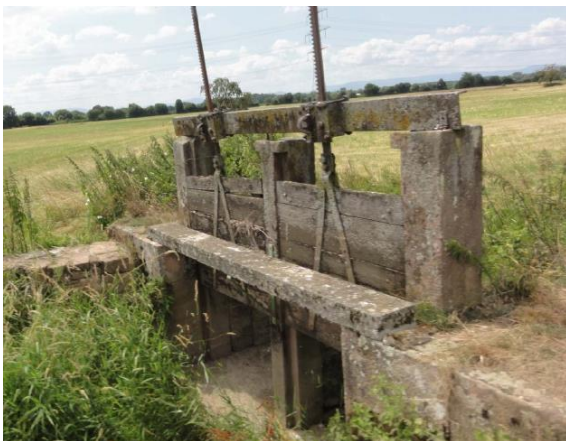
Abb. 3: Ein Hauptstellfalle mit Handkurbel (links) und eine Nebenstellfalle, die händisch hochgezogen wird (rechts). Fotos: Referat 56, RP Freiburg
