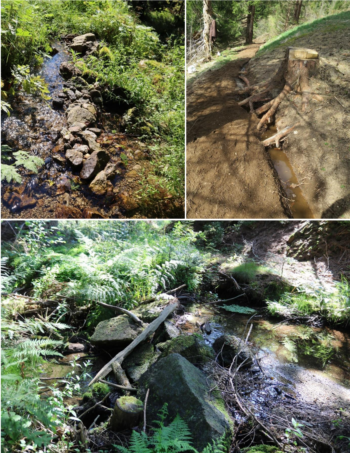
Abb. 2: Links oben: Sohlschwelle aus Steinen. Auf der linken Seite der Steine läuft der Wässergraben hangparallel weiter, rechts davon fließt der Hauptbach hangabwärts. Rechts oben: Teilweise verlaufen die Gräben unter Baumwurzeln hindurch. Die meisten Gräben sind einen Spaten breit und einen Spaten tief. Unten: Sohlschwelle aus Steinen und Treibsel. Der Wässergraben rechts von der Sohlschwelle wurde in einen Forst erweitert, der dadurch wieder in den Ursprungszustand zum Niedermoor / Moorfichtenwald umgewandelt werden soll (siehe Abb. 6). Fotos oben links und unten: Thomas Köhler, Foto oben rechts: Tobias Windmaißer
