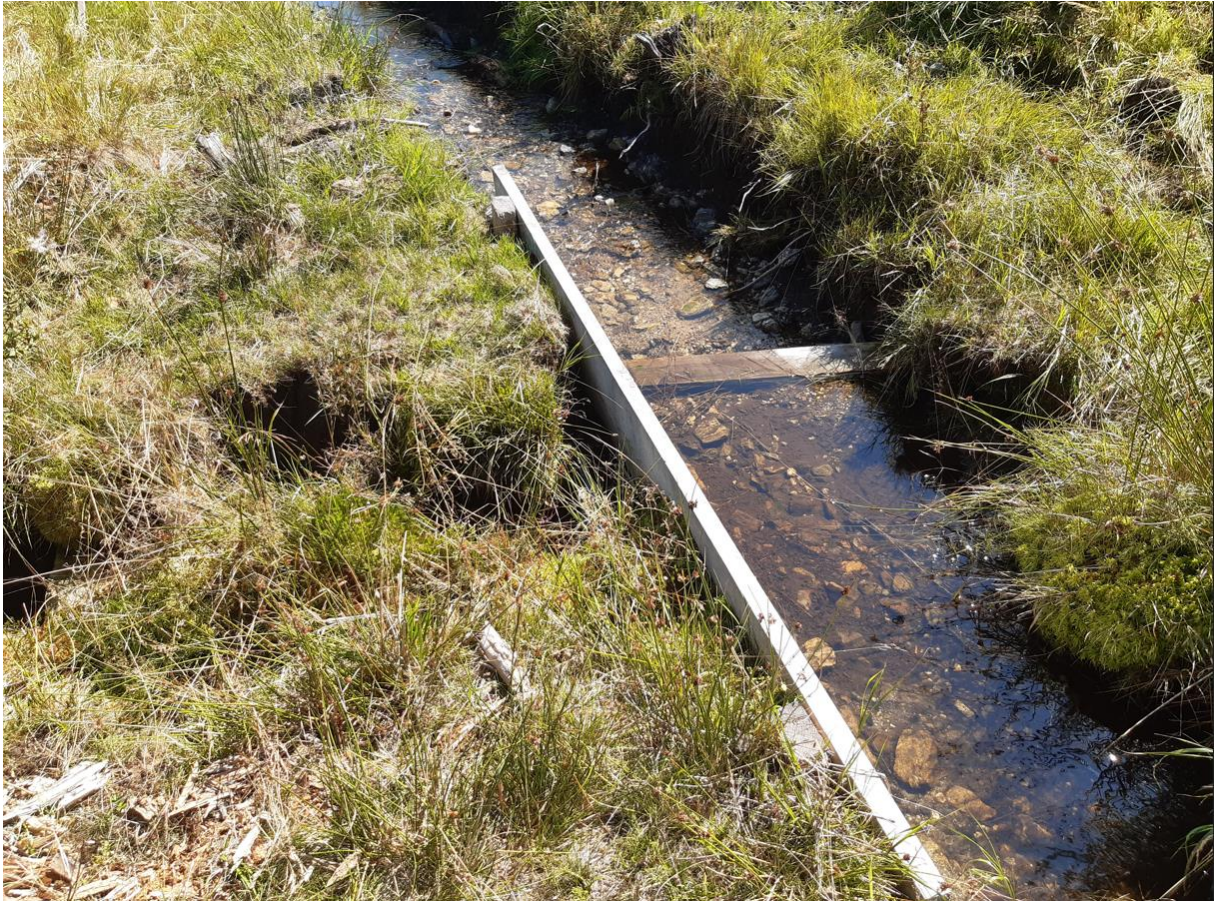
Abb. 8: Eine Staukonstruktion, die Gewässerdurchgängigkeit gewährleistet und verhindert, dass die maximale Wassernahmemenge überschritten wird. Die Sohlschwelle links befindet sich am Eingang des Grabensystems. Das Holzbrett im Bach lässt einen Spalt zwischen der Brettunterkante und Gewässersohle.
